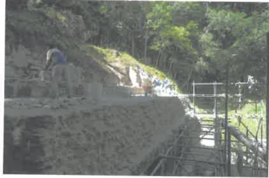
Edificio 389, trabajos de recuperación de volumen en el basamento del segundo piso.
