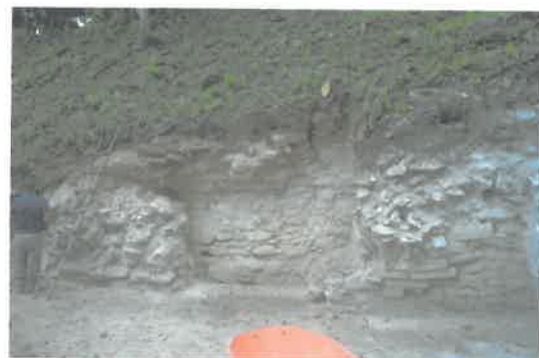
Edificio B-17, fachada oeste al norte de escalinata central.
